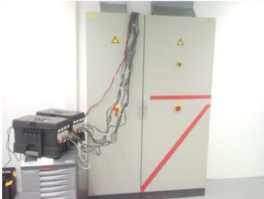
Slika: Primer prikločitve merilcev na električno omarico.
